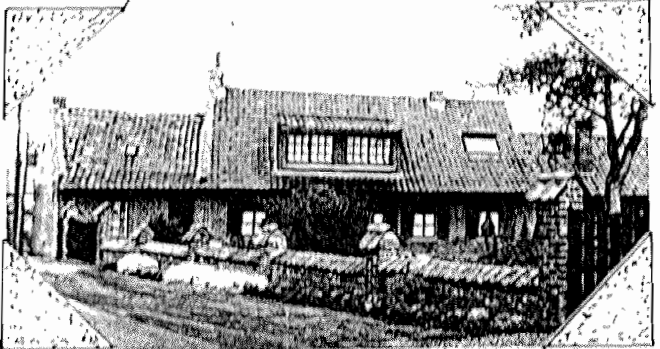
Deux chiens-assis accolés, c'est tout pour la surface de toiture.
