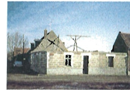
Angle de la rue Coperec et du grand Dem : maison en reconstruction.
