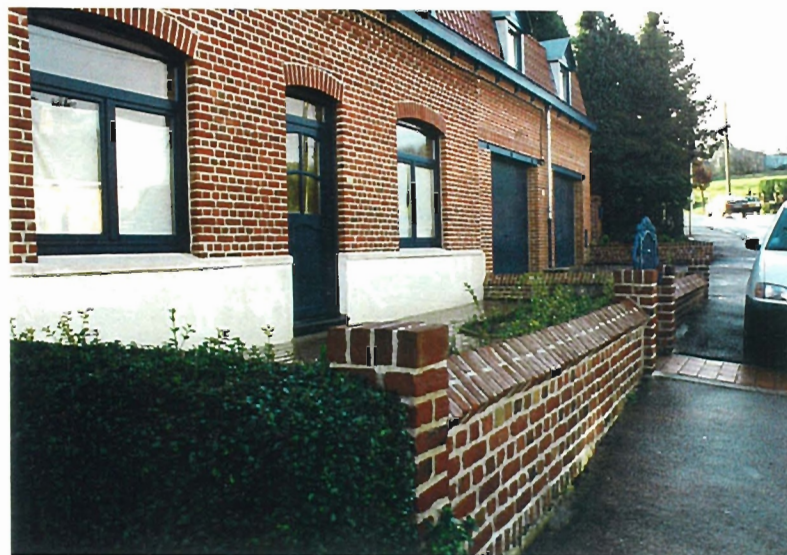
Muret ceinturant un jardinet
