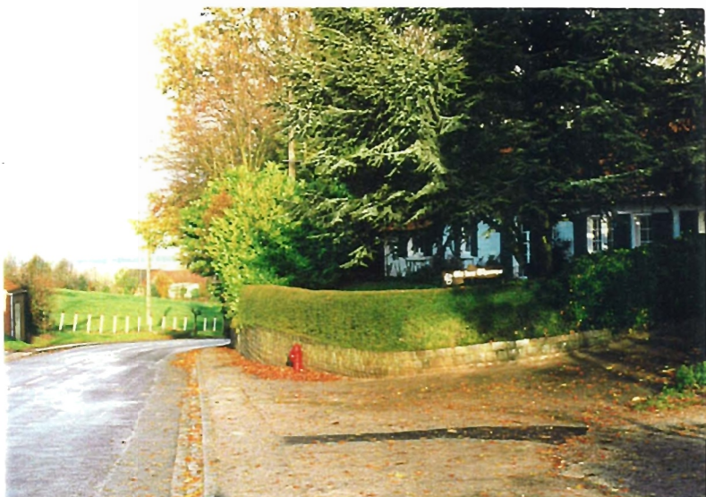
Muret rehaussé d'une haie
