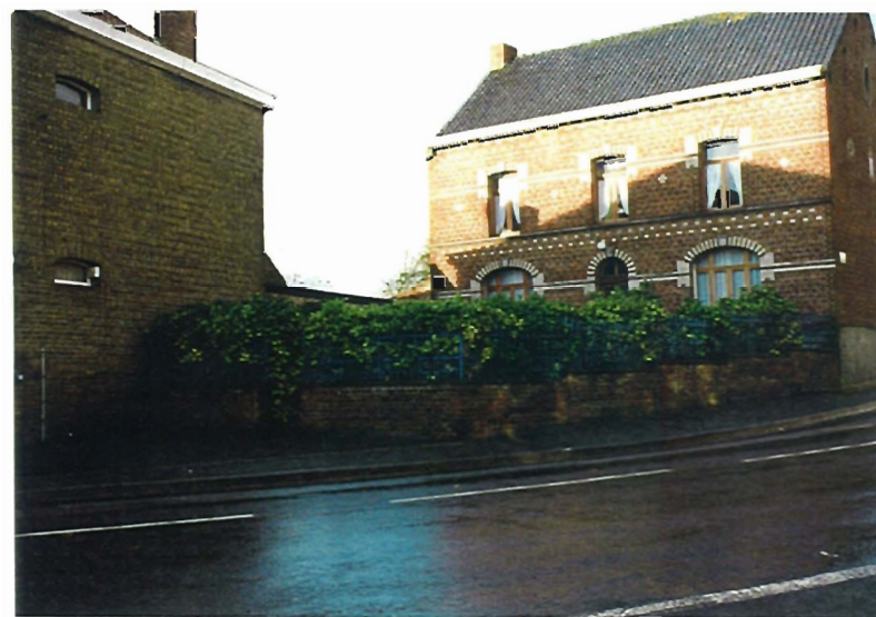
Muret avec redents, grille et haie
