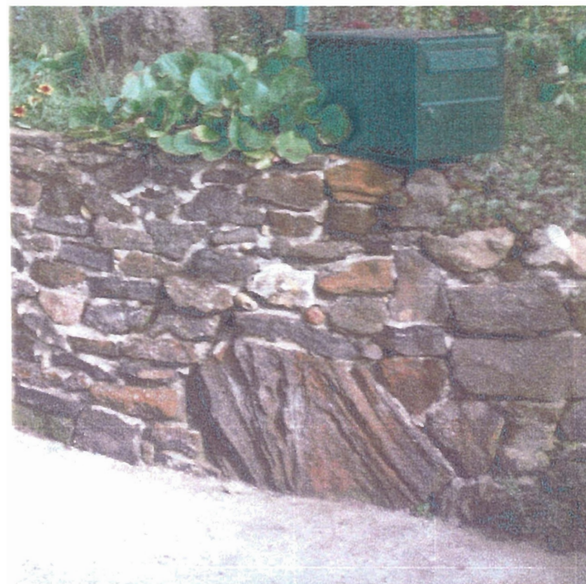
Grès ferrugineux utilisé dans quelques constructions
