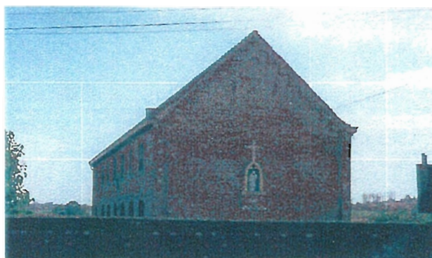
Pignon rue de Poperinghe
