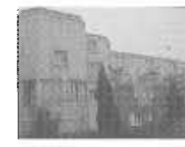
Arrêt n° 2 : " Van Gogh 2 " adresse : rue Vermeer date : 1980 nombre de logements : 59 (7511m2) architectes : Legros et Guistain (GGK) promotion : HLM CUDL Roubaix et Tourcoing photo : CAUE du Nord
