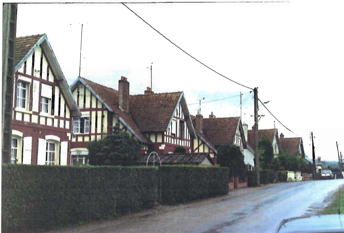
Rue des Laguettes Pavillonnaire ouvrier de l'entre-deux-guerres lié au développement industriel ( usine de la rue Léo-Lagrange)
