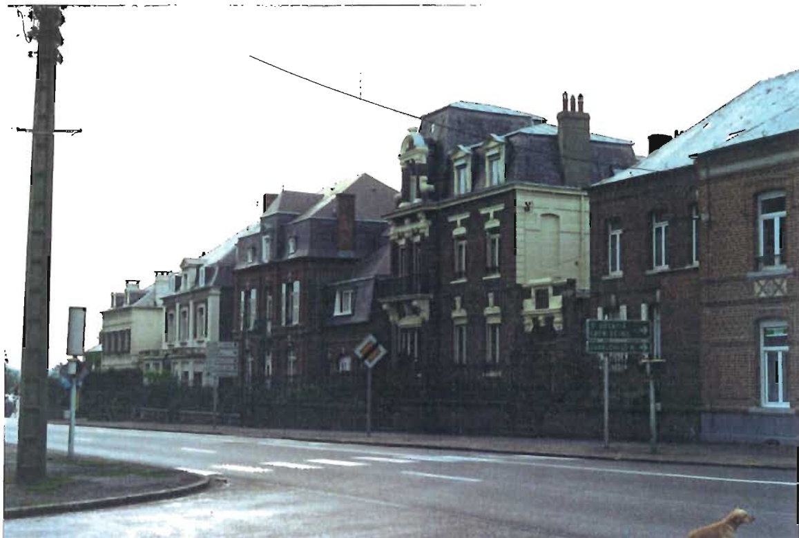
Route de Landrecies D 962 Maisons "bourgeoises" liées au développement périphérique de la ville d'Avesnes
