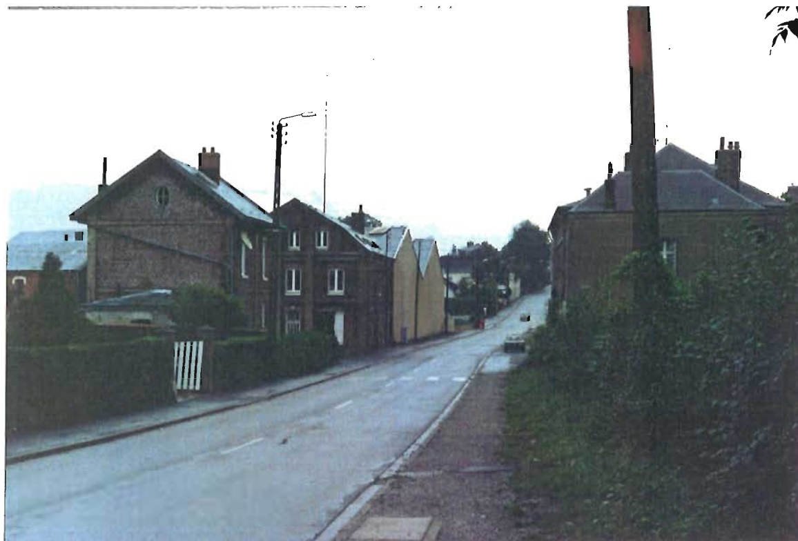
Rue Léo-Lagrange La remontée sur le village ancien Marquage du pont et identifier au sol les séquences visuelles.
