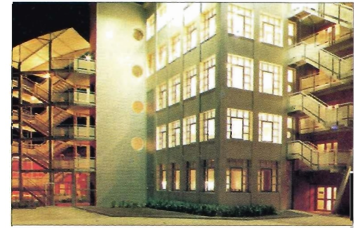
. Parc des expositions et d'animation "Espace Sculfort" - Maubeuge, Nord . Jacques Corbeau, Christian Wojciechowski, architectes - Alain Carpentier, Maire.
