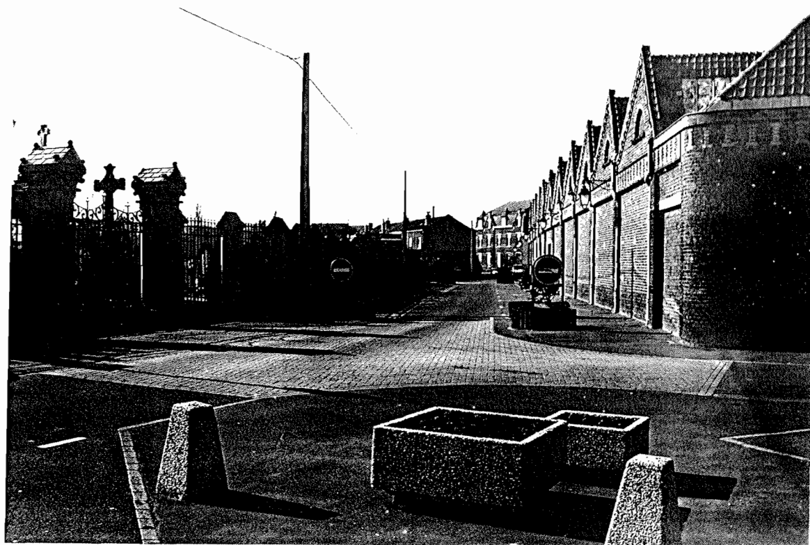
L'aire de stationnement située à l'entrée de la rue de l'Egalité - Vue vers la rue du Bas Chemin.
