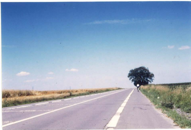
Chapelle aux arbres sur le C.D. 90
