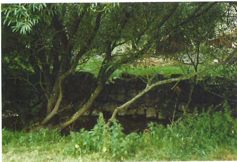
BERGES DE LA THURE LIEU-DIT MOULIN DE CATAYA
