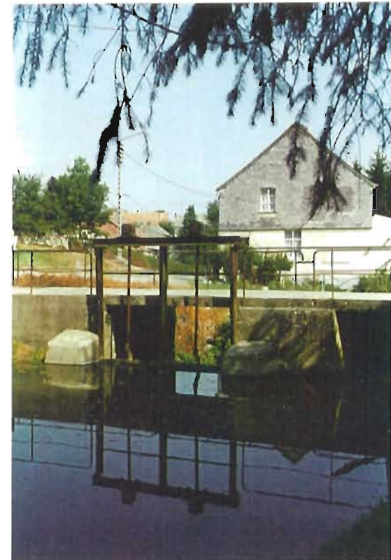
PASSERELLE ET ECLUSETTE SUR LE BRAS DE DECHARGE DE LA THURE LE LONG DE L'ETANG FEDERAL, SORTIE SUD DU VILLAGE
