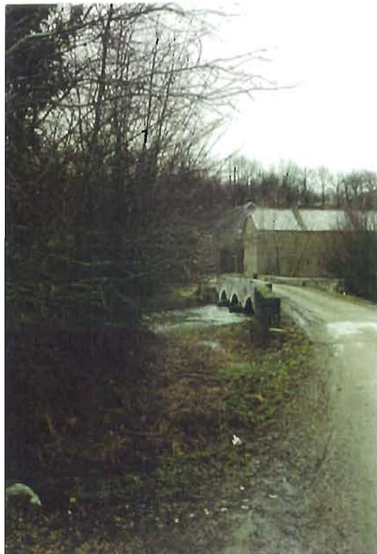
LE PONT COUROUX ETEND SES 3 ARCHES SUR LAHANTE DANS LE HAMEAU DE REUGNIÉ
