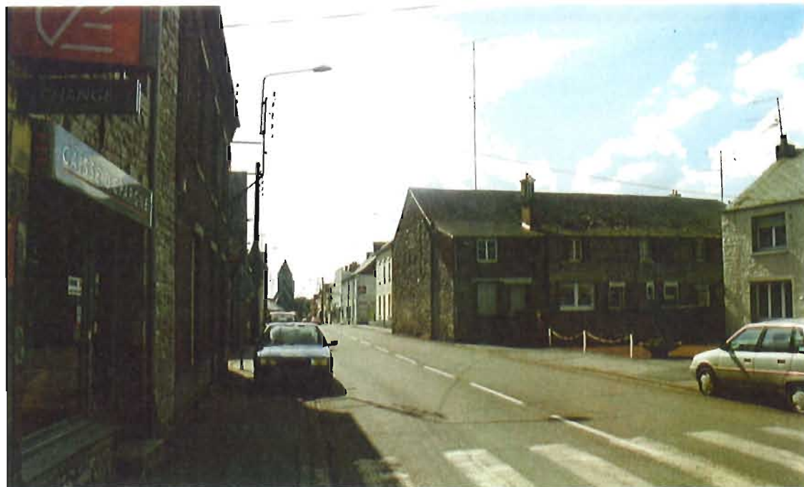
Le pignon présenté a depuis peu été arasé pour rétablir la continuité piétonne. Malgré cette démolition dommageable, les deux bâtiments se faisant front continuent toutefois à marquer la limite entre les sous-séquences.
