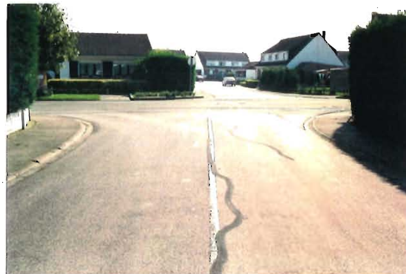
Carrefour avec la rue de la commune. Aspect très minéral, unilormité des matériaux, absence de traversée piétonne
