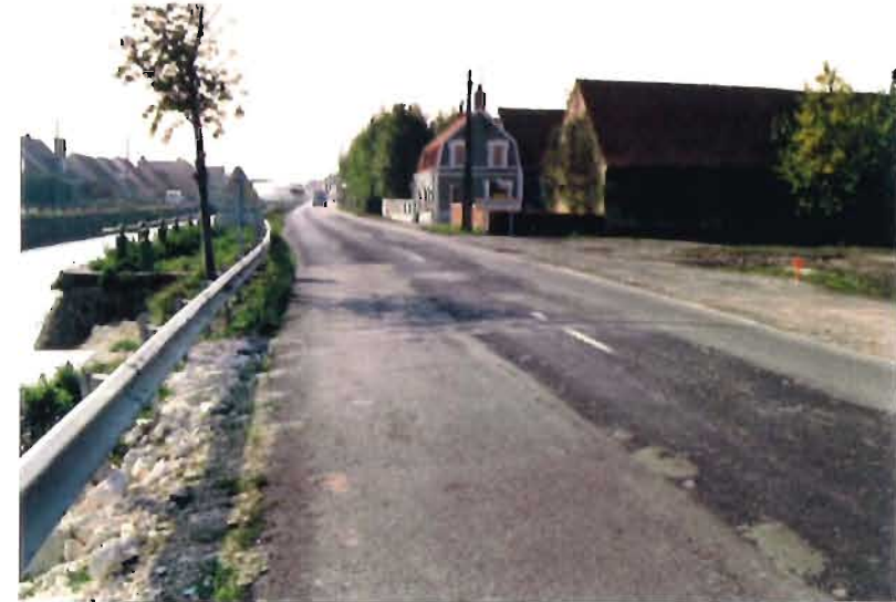
Fin du perré en moellon. Les remblais calcaires déprécient l'image des bords du canal et rend toute végétalisation impossible. Pas de trottoir côté droit face à la dernière habitation (ferme).
