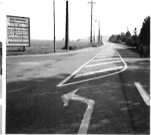
Vers le Grand Mille Brughe. Discontinuité du trottoir côté habitations
