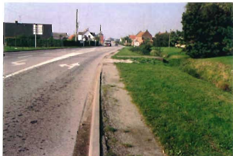
Le CD 52 après le franchissement du pont après l'entrée au Parc du Lac d'Armbouts : pas de trottoir
