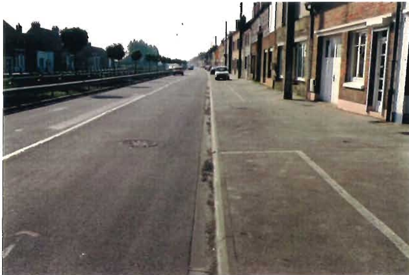
Pas de différenciation dans les revêtements entre espace carrossable et espace piétonnier. Plantation d'arbre boule en disproportion par rapport à l'échelle de la voie.
