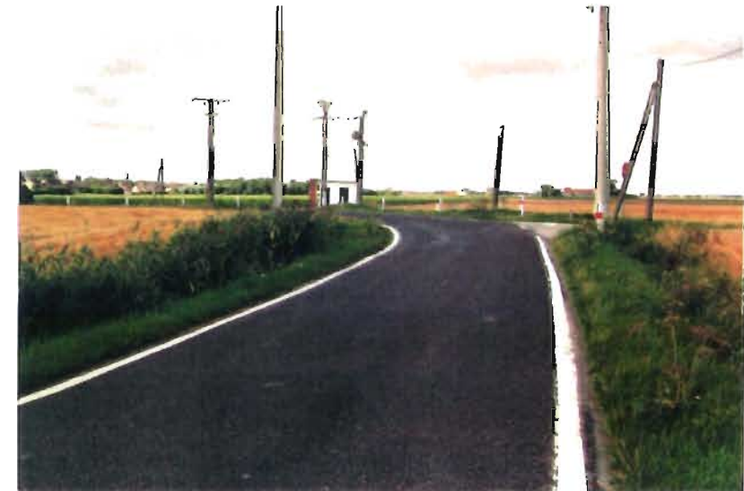
Encombrement de poteaux - voie étroite - virage dangereux
