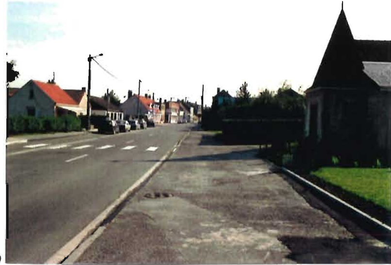
Passage piéton entre l'aire de jeux et la résidence des Eglantiers à conlorter. Lotissement Malson Familiale de Cambrai au fond.
