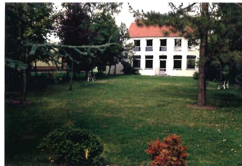
Des liens à créer entre la salle Berger et la maison associative. Plantations arbustives à renforcer
