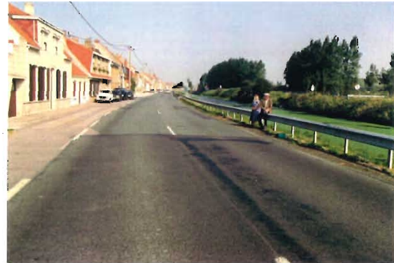
Plus de véritable trottoir côté gauche, face aux dernières habitations. Pas de piétonnier côté canal. Glissière de sécurité donnant une connotation autoroutière à la voie.
