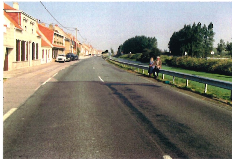
Plus de véritable trottoir côté gauche, face aux dernières habitations. Pas de piétonnier côté canal. Glissière de sécurité donnant une connotation autoroutière à la voie.
