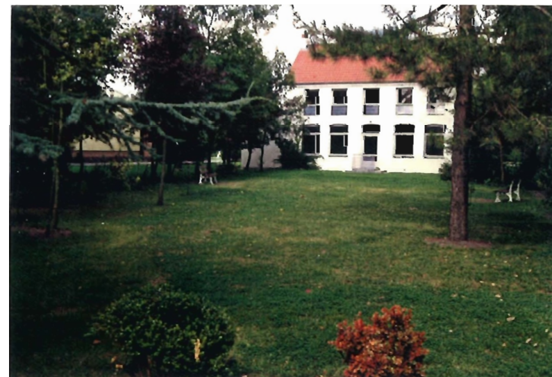
Des liens à créer entre la salle Berger et la maison associative. Plantations arbustives à renforcer
