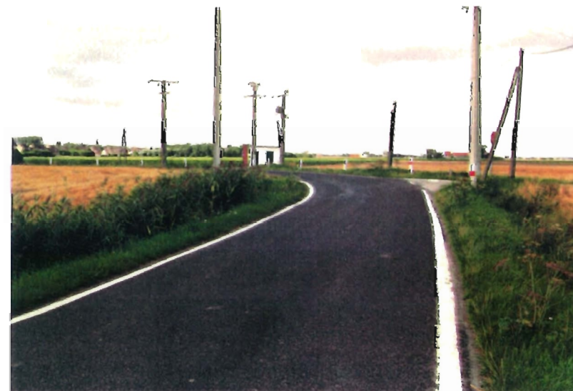
Encombrement de poteaux - voie étroite - virage dangereux
