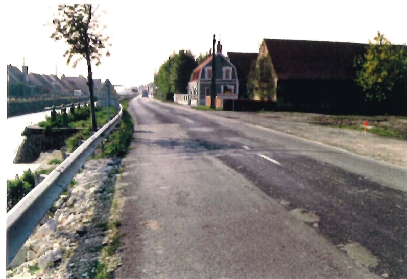
Fin du perré en moellon. Les remblais calcaires déprécient l'image des bords du canal et rend toute végétalisation impossible. Pas de trottoir côté droit face à la dernière habitation (ferme).
