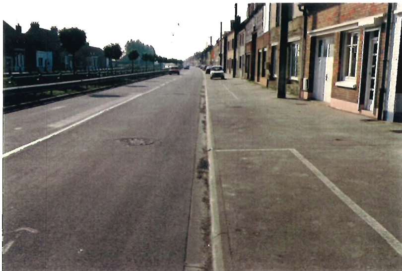
Pas de différenciation dans les revêtements entre espace carrossable et espace piétonnier. Plantation d'arbre boule en disproportion par rapport à l'échelle de la voie.
