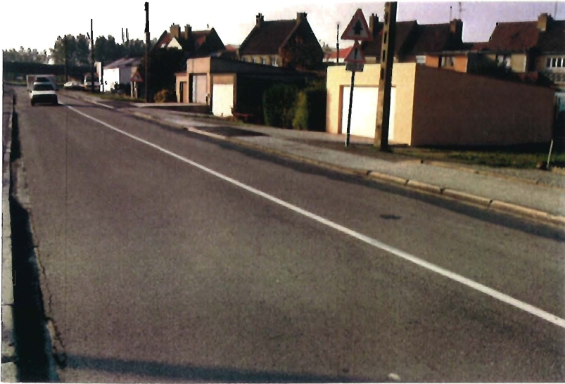
Des espaces publics difficiles à gérer en raison des sorties de garages et des dénivellations importantes. Des fonds de parcelles peu esthétiques et hétéroclites.
