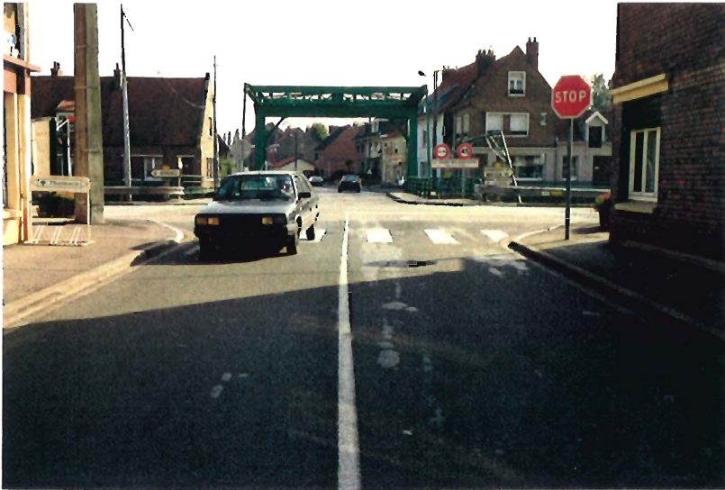
Rétrécissement des trottoirs au niveau du café tabac accentuant l'effet de "goulot" en direction de Steene. A l'inverse, stationnement sur chaussée accentuant l'effet de surlargeur de la voirie.
