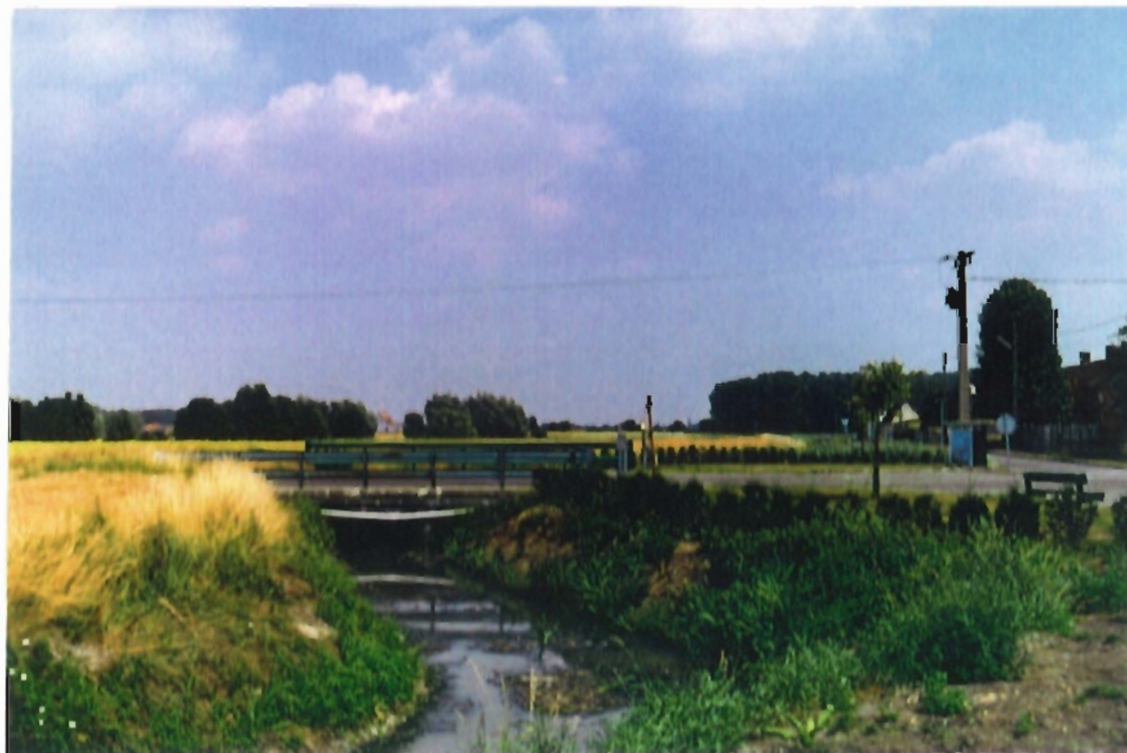
Ballustrade faite d'une glissière de sécurité à l'entrée Nord...
