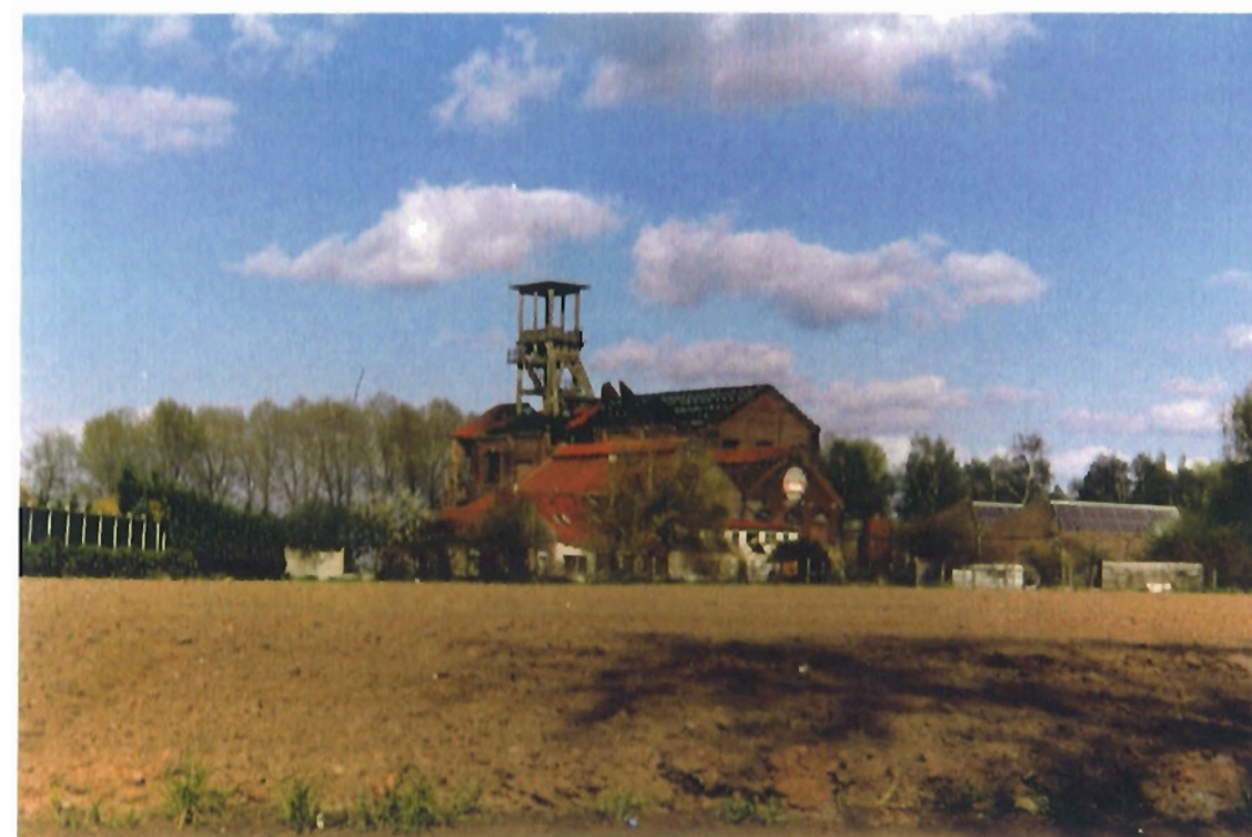
La fosse n°2 à ANHIERS : un patrimoine industriel à préserver
