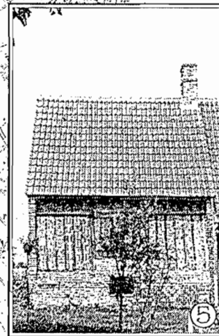
Le torchis a été remplacé par des briques ; les colombages d'orne sont toujours présents, de même que les dessins de briques sur le bas du mur.
