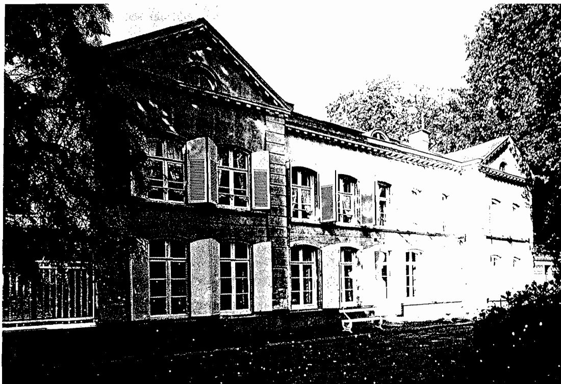
Socx, manoir du "Klapouck", route de Saint-Omer, 1. Cette demeure entourée d'un beau parc, fut élevée avant 1820, vraisemblablement à la limite des XVIII e et XIX e siècles. Suivant le style néoclassique en vigueur à l'époque, un épais enduit dissimule la brique qui constitue le gros oeuvre, mais, assez curieusement, les fenêtres sont encore couvertes d'un arc segmentaire, forme habituellement bannie à cette époque
