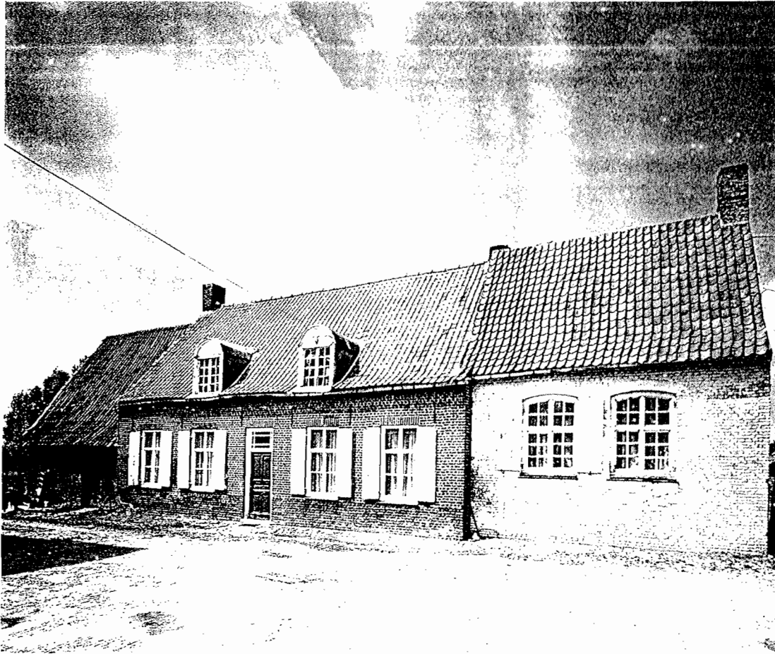
West-Cappel, C.R. 2, corps de logis et écurie (élévation sur la cour). Ce logis comporte comme on le voit souvent deux ailes bâties dans le prolongement l'une de l'autre. L'aile plus élevée en brique jaune, où se trouve la "voûte", date vraisemblablement de la fin du XVIII e siècle ; l'aile basse en brique rouge es de 1883. L'écurie est, comme dans bien d'autres cas, située dans le prolongement du logis et non incluse dans les étables car les chevaux, qui réclament toujours placés à proximité de l'habitation
