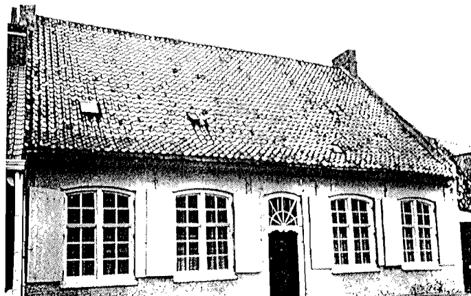
Belle maison flamande du XVIII e siècle. On notera plus particulièrement les vent-berges qui protègent la toiture, la dalle en fer forgé et l'imposte.
