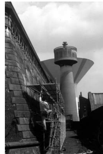
La Louvière - 3 générations de réservoirs d'eau.
