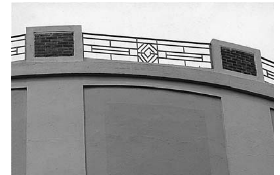
modèle 1930 en béton - extérieur de la cuve et garde-corps
