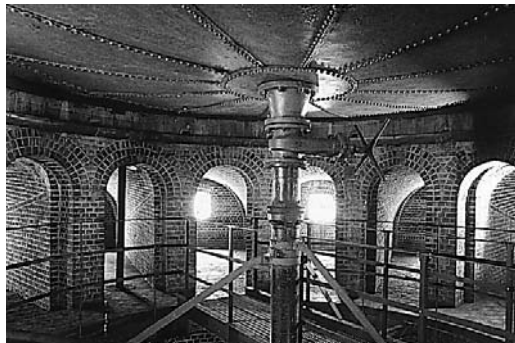
modèle 1885 en brique - sous-face de la cuve métallique
