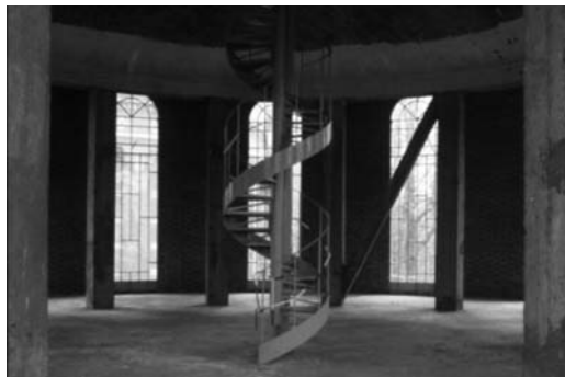
modèle 1930 en béton - escalier central au 1er étage
