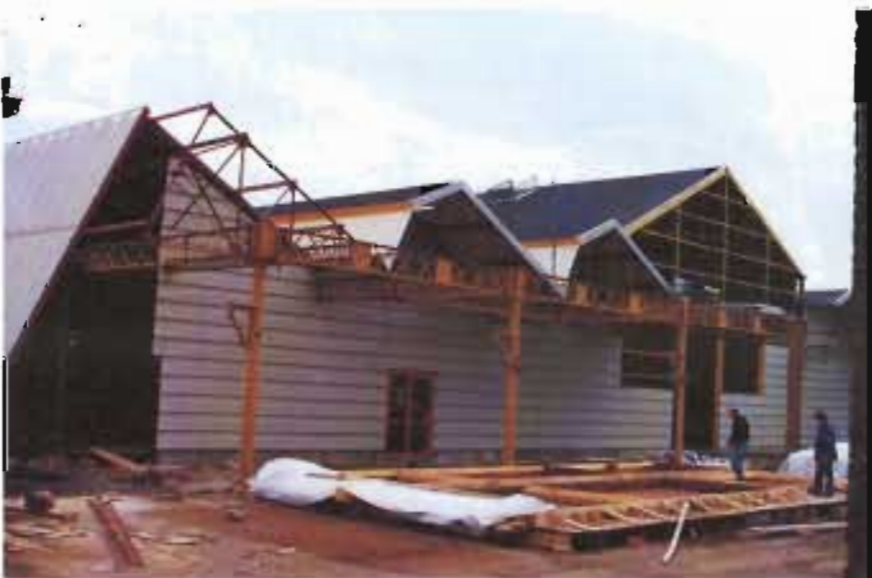
MAUBEUGE - espace Sculfort, réhabilitation, état en janvier 1991 - C Wojciekowski arch.
