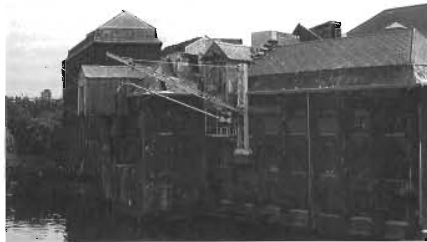
Ancien moulin Despretz à Marquette. 1858 (démoli)
