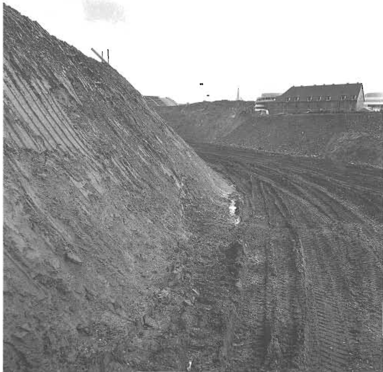
Site gare T.G.V. Traces, Mai 1992
