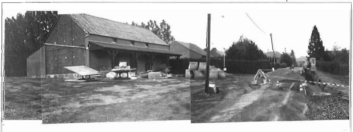
La salle des fêtes et ses abords pendant les travaux de voirie
