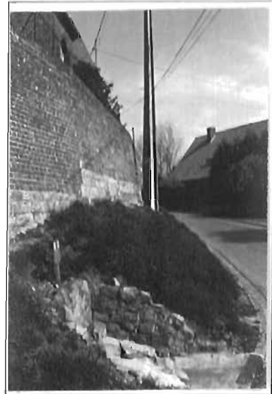
Soutènement au chevet de l'église
