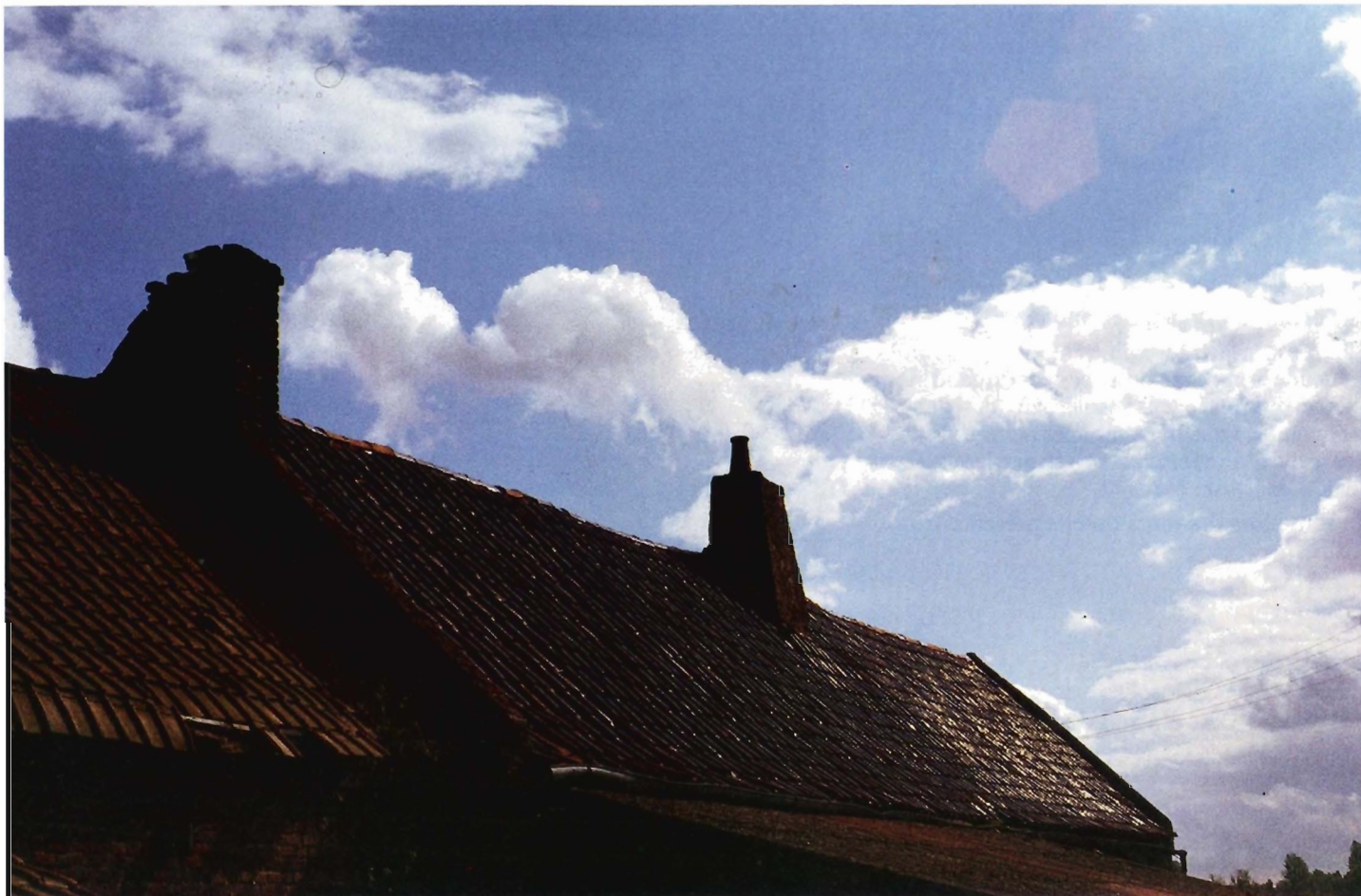
32. Ferme Lansau. Versant de toiture.
