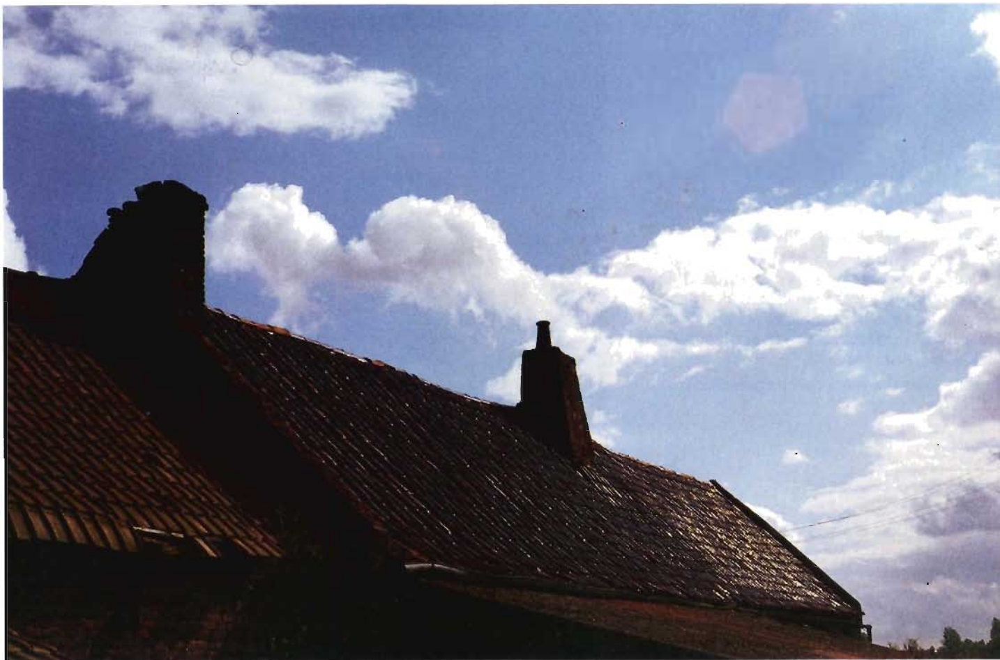
32. Ferme Lansau. Versant de toiture.
