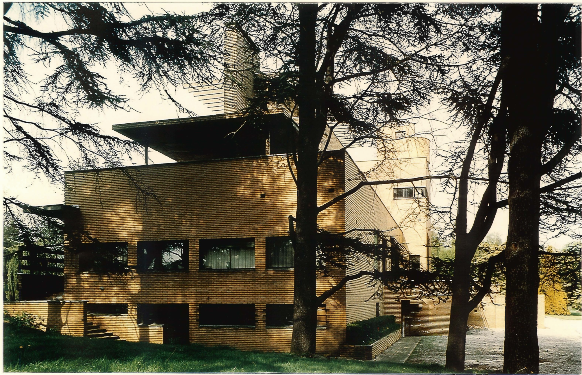
4 - Le pignon Ouest, à travers les arbres.
