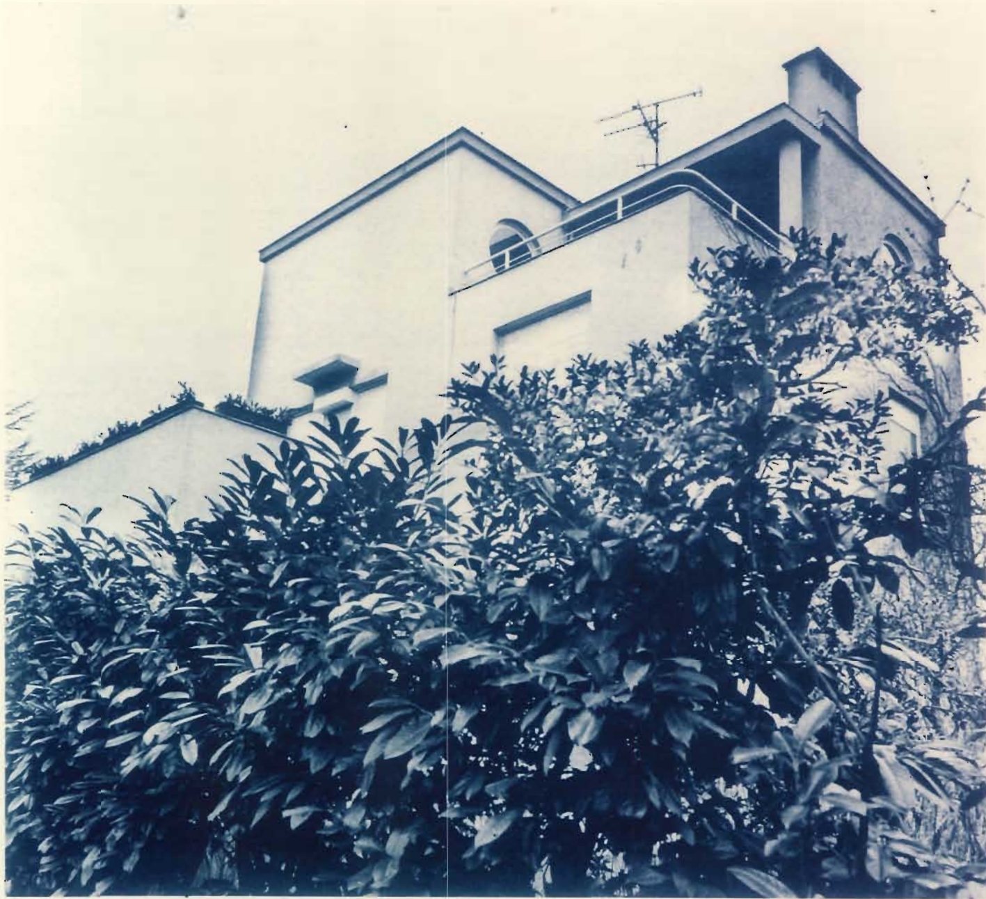
Villa pour ses parents - 1928 143, boulevard de Lyon, Roubaix Pierre Neveux (1902-1972), architecte à Roubaix.
