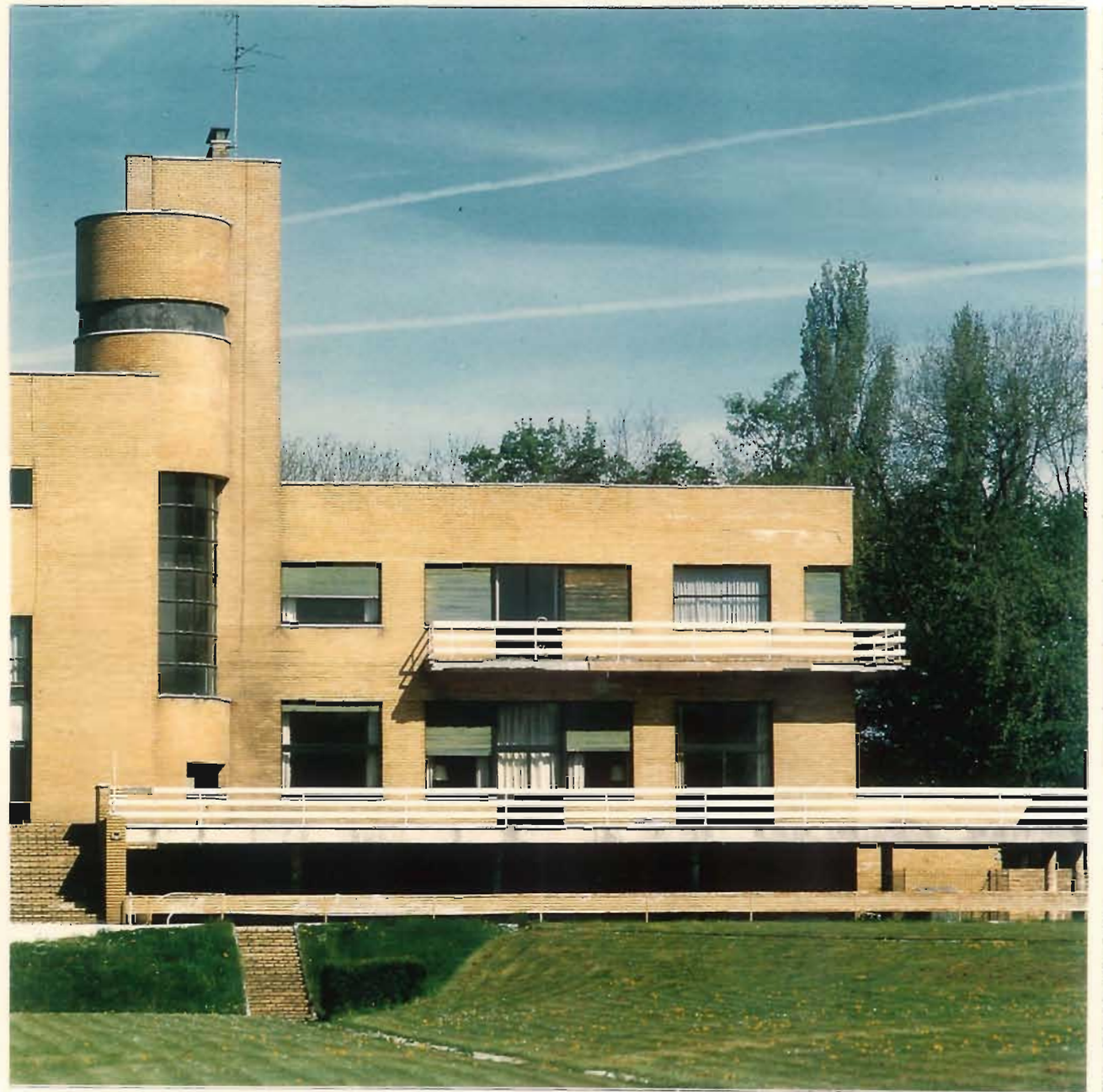
5 - L'angle sud-est : au premier plan, la piscine. La volumétrie illustre bien le propos de Mallet-Stevens ; "L'architecte sculpte un bloc énorme ; la maison".
