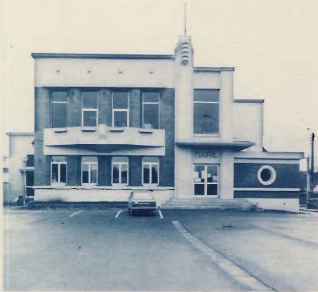
Mairie de Saultain - 1938. Henri Deporte (1895-1955), architecte à Valenciennes.
