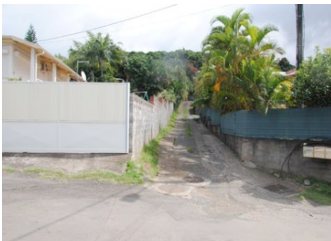
Servitude de passage conduisant aux nouvelles micro-crèches
