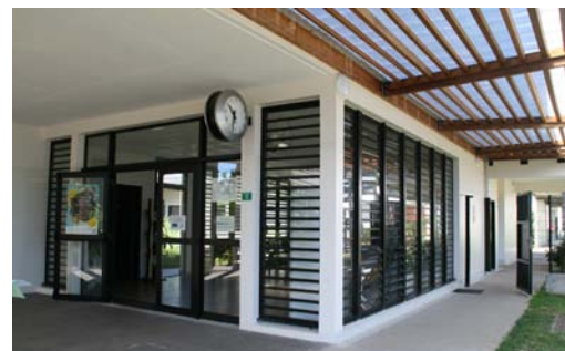
Accueil - bâtiment administratif
