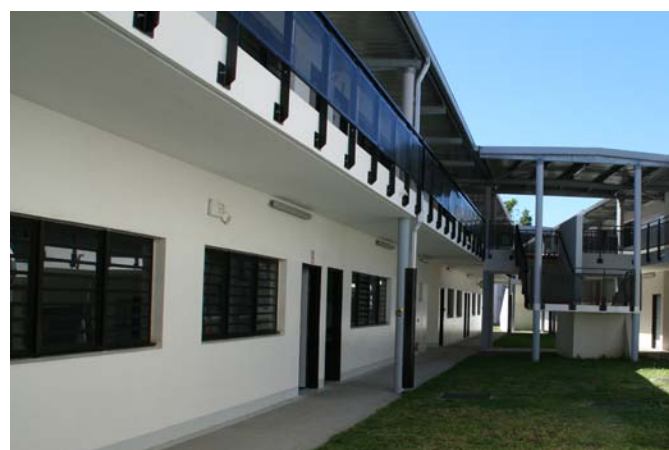
Coursives ombragées des salles d'enseignement général
