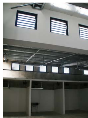
Ventilation traversante des ateliers
