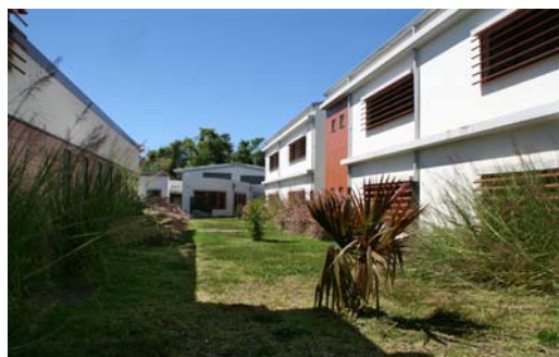
Espace planté entre bâtiments perpendiculaire à l'axe central
