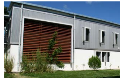
Protection solaire façade Nord des ateliers maçonnerie et peinture
