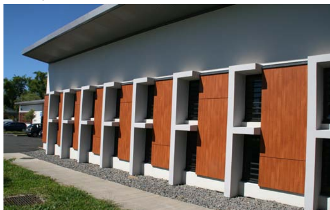
Bardage Trespa placé sur la partie basse de façade non protégée par le débord de toiture
