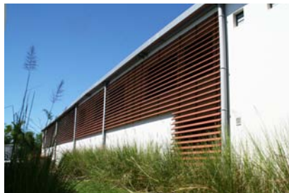
Protection solaire façade Nord des ateliers maçonnerie et peinture
