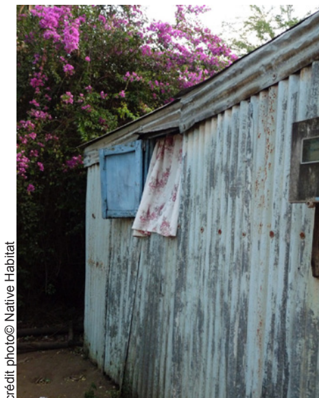
Maison existante en tole
