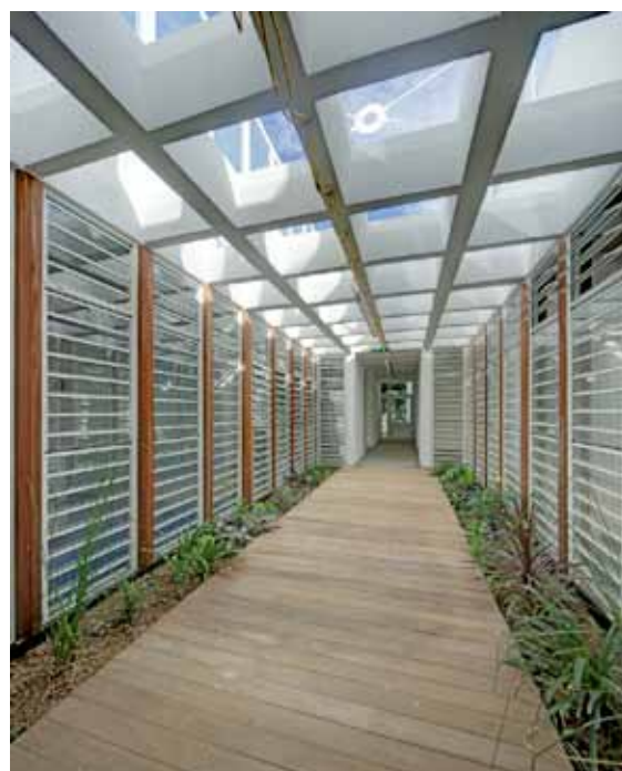
Patio : travail de percement sur le plancher à caissons et augmentation de la hauteur de tirage par des parois vitrées pour obtenir l'effet dépressionnaire nécessaire sans occulter la lumière.
