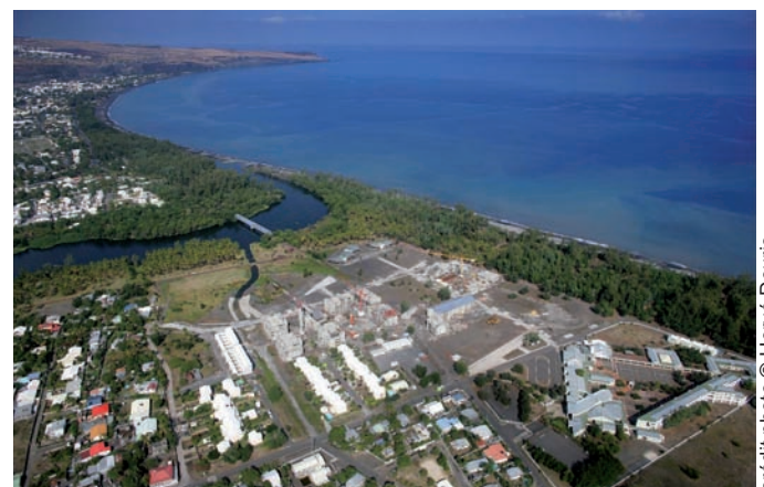
Site en travaux
