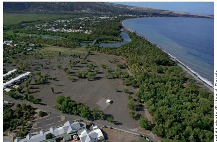
Site avant travaux
